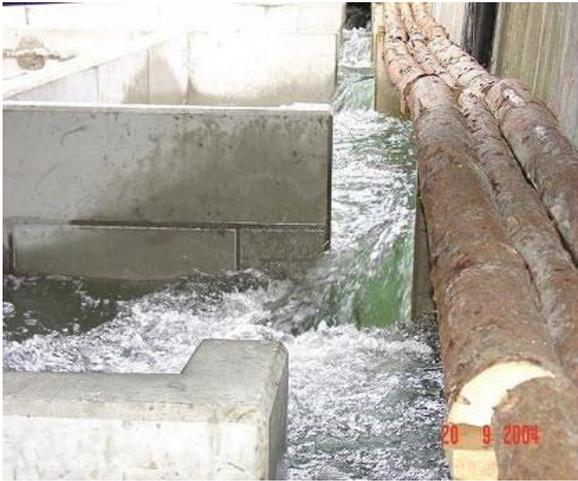
Abb. 8.14: Durchgangsmöglichkeit für Biber auf einem Holzsteg über dem Fischbecken des Kraftwerkes Augst. Auf Rampen wie dieser können die Biber die Kraftwerke passieren. Da die Biber Fließgewässer nur selten verlassen, sind sie bei Hindernissen wie Wasserkraftwerken auf solche Hilfen angewiesen (Abb. aus INTERNET: BIBER).
