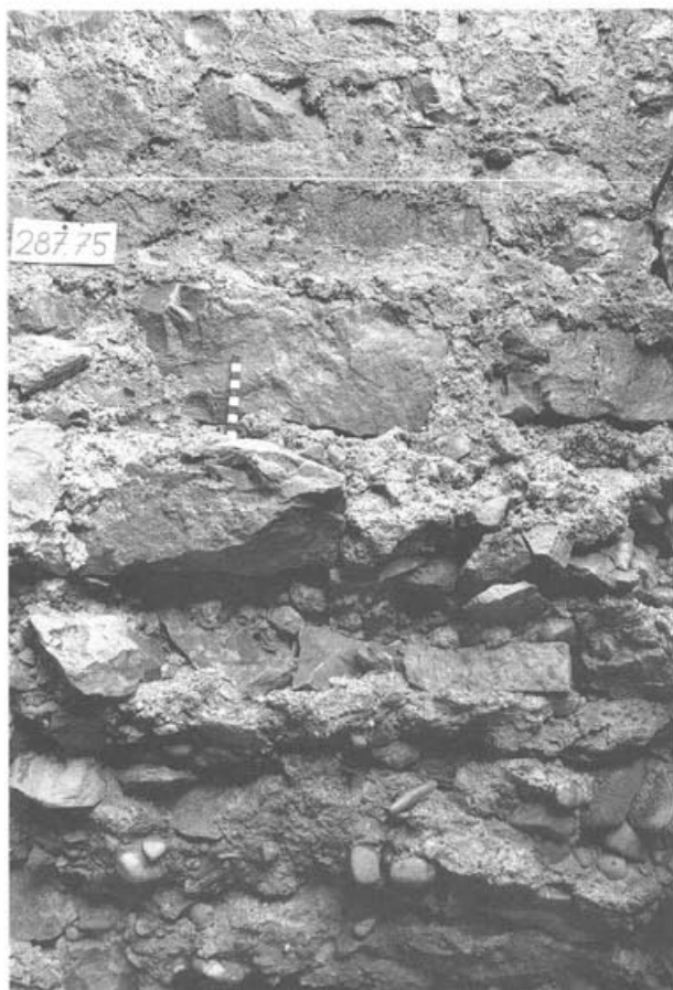
Abb. 23 Augst BL, Grabung 1990.53. Detail an der jüngeren Basilika-Stützmauer. Im unteren Bildteil ist das leicht einziehende, direkt in die Baugrube gemauerte Fundament zu erkennen. Der fast noch in baufischem Zustand erhaltene untere Teil des aufgehenden Mauerwerkes ist – wie u.a. auch die anhaftenden Kiesel zeigen – unmittelbar nach dem Hochziehen der Mauer wieder mit angeböschtem Erdreich verdeckt worden (vgl. auch Abb. 20,C). Blick nach Westen.
