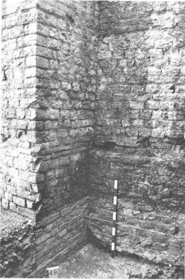
Abb. 18 Augst BL, Grabung 1990.53. Blick in den Winkel zwischen Strebepfeiler 8 (MR 3, links im Bild) und der Curiamauer (MR 1, rechts im Bild). Der Bildausschnitt zeigt, dass der Strebepfeiler 8 – im Gegensatz zur Curiamauer – ab Oberkante des Fundamentklotzes auf Sicht gemauert worden ist. Der mit dem Massstab gekennzeichnete Teil der deutlich gröber strukturierten Curiamauer war in der Antike in eine heute verschwundene Böschung eingetieft. Er steht – wie die Baufuge zeigt – bis auf die Höhe des ersten Ziegeldurchschusses auch nicht im Verband mit dem Strebepfeiler 8. Das schmale Erdband zwischen der Oberkante des Fundamentklotzes und der Curiamauer spricht ebenfalls dafür, dass der untere Teil des Strebepfeilers und die Curiamauer nicht gleichzeitig, sondern etappenweise hochgezogen worden sind. Blick nach Osten.
