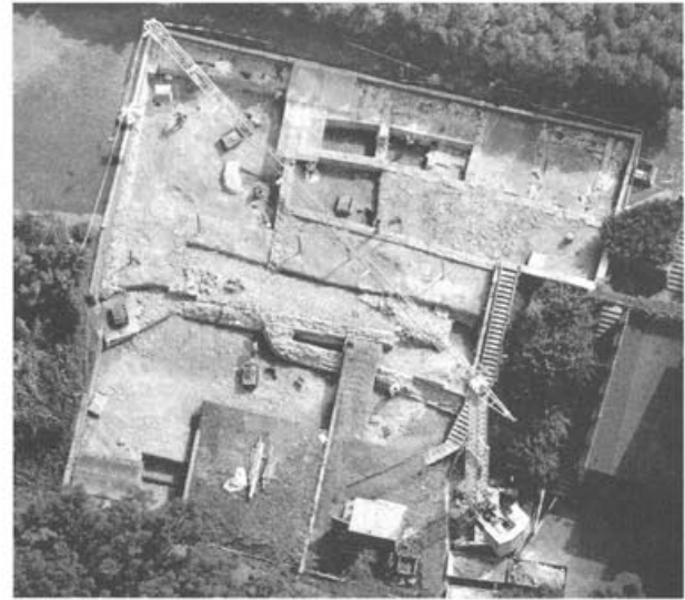
Abb. 3 Augst BL, Grabung 1991.51 (Kastelen). Luftbildaufnahme der Grabungsfläche. Zu erkennen sind die Mauerkrone der Insulae 1 und 2 (Phase I) und der «Zerstörungsschutt» der Phase II. Blick von Norden.
