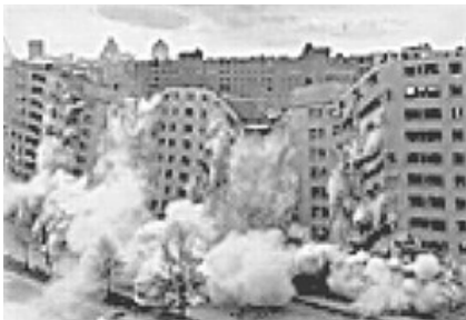
Abbildung 1: Am 15. Juli 1972 wurden in St. Louis drei der dreiunddreissig Wohnscheiben von Pruitt-Igoe gesprengt.
