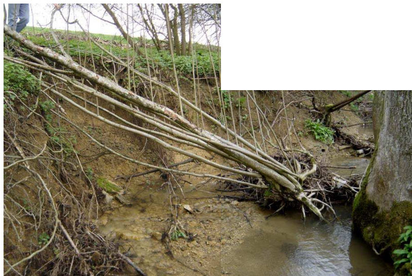
Abb. 5.14: Uferabbruch im Länenbach vor und nach dem Hochwasser vom 10.04.2006 (Fotos: Christian Katterfeld)
