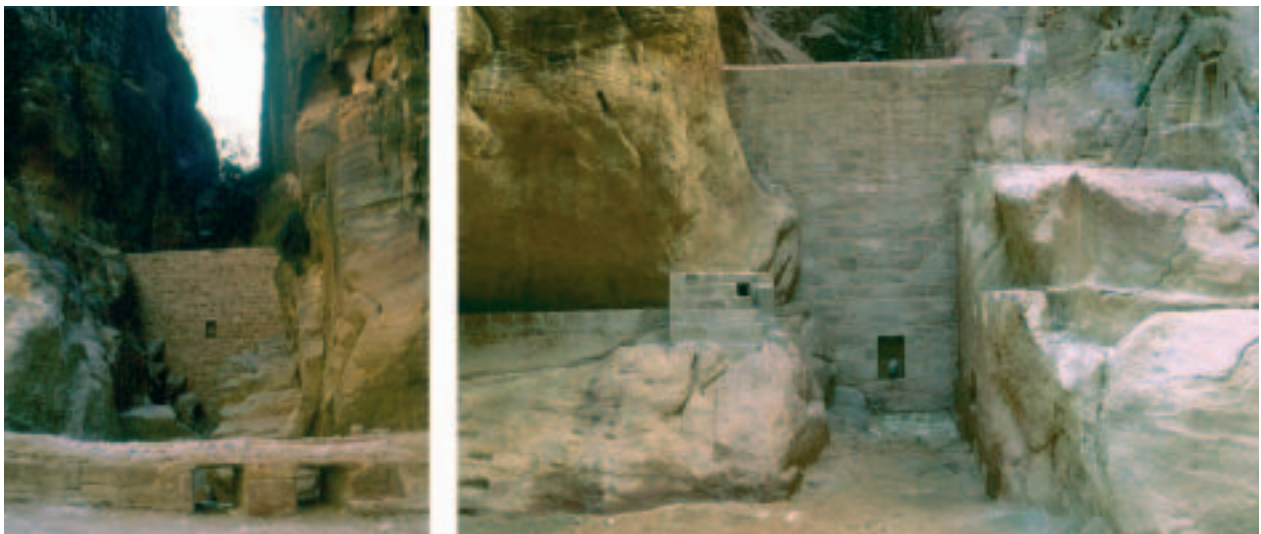
Abb. 27: Blick an die talseitige Front eines rekonstruierten Rückhaltedamms in einem Seitental (Madress) des Siq in Petra (der niedrige Kanal im Vordergrund des linken Bildes ist der Frischwasseraquädukt nach Petra).
