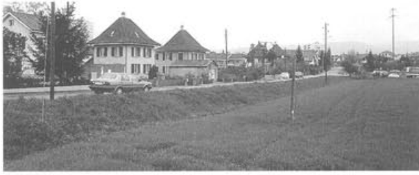
Abb. 26 Augst/Pratteln, Region 10 (Grabung 1994.60). Ansicht der Ostflanke des auf dem linken Ergolzufer verlaufenden, bis in die frühe Neuzeit genutzten Wegdammes der Verbindungsstrasse zwischen den beiden römischen Hauptverkehrsachsen (vgl. Abb. 25 oben links). Blick nach Westen.
