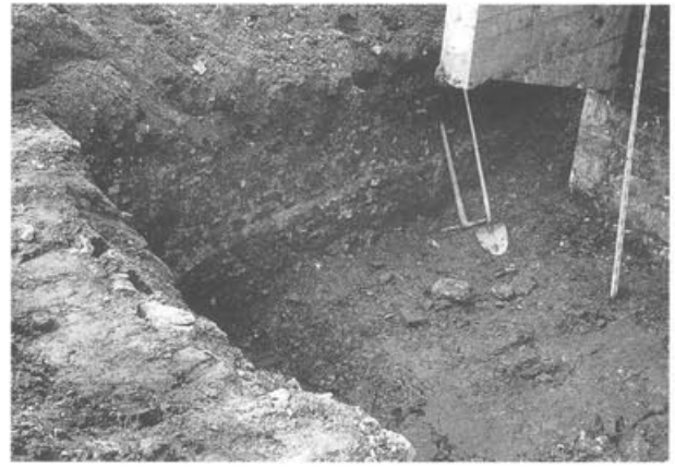
Abb. 18 Augst, Insula 24 (Grabung 1994.57). Blick in die Baugrube des unterkellerten Wintergartens der Liegenschaft Minervastrasse 2 mit den seinerzeit (Grabung 1958.52) nur summarisch dokumentierten Mauern 36 und 42 (links). Blick nach Osten.
