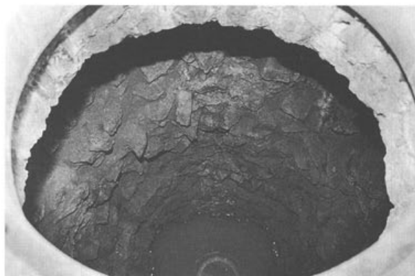
Abb. 20: Augst BL, Region 2,B (Grabung 1997.75). Blick in den im Jahre 1956 mit einer Betonröhre versteiften und mit Zement beworfenen, vermutlich zwischen 1582 und 1585 von A. Ryff angelegten Suchstollen. Auf der Sohle des Schachtes hat sich eingedrungenes Regenwasser angesammelt (vgl. Abb. 21,2).
