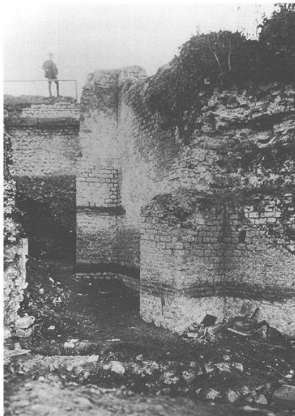
Abb. 3: Augst BL, Region 1, Insula 13 (Grabung 1907/1908.60). Ansicht der Curia während der von Karl Stehlin durchgeführten Freilegungsarbeiten. Blick von Osten.
