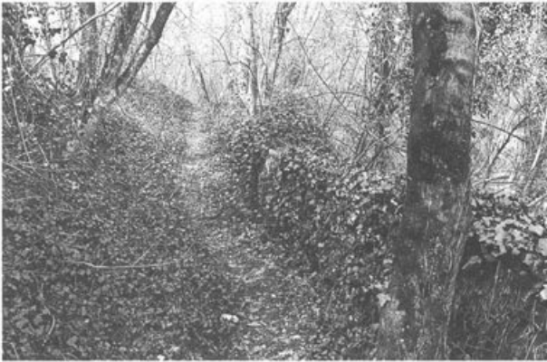
Abb. 17: Pratteln BL, Region 10 (Grabung 1997.74). Blick auf einen besser erhaltenen Abschnitt des spätmittelalterlichen Mühlekanals in der Flur Widen. Die mächtigen Sandsteinquader der ergolzseitigen Kanalwange (rechts; vgl. auch Abb. 18) sind vollständig überwuchert. Zur Lage vgl. Abb. 15,2.
