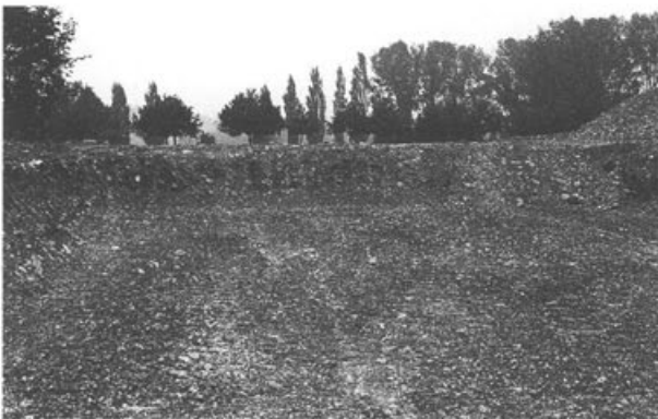
Abb. 11: Augst BL, Region 15 (Grabung 1997.73). Blick über den dicht unter der Humuskante anstehenden Schotter der Ergolz im Bereich der Baugrube der Liegenschaft Schiffländeweg 10. Der Befund bezeugt, dass das südlich des Gräberfeldes Rheinstrasse (Region 15,A) liegende Areal in römischer und nachantiker Zeit nicht überbaut war (vgl. auch Abb. 10).
