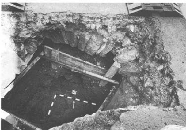
Abb. 8: Augst BL, Region 10,B (Grabung 1997.54). Blick an das bei Bauarbeiten durchschlagene, aus Sandsteinquadern gefügte Gewölbe des spätmittelalterlichen Mühlekanales. Der freigelegte Abschnitt wurde offenbar noch lange als Leitungstunnel benutzt und erst in jüngerer Zeit aus Sicherheitsgründen verfüllt.
