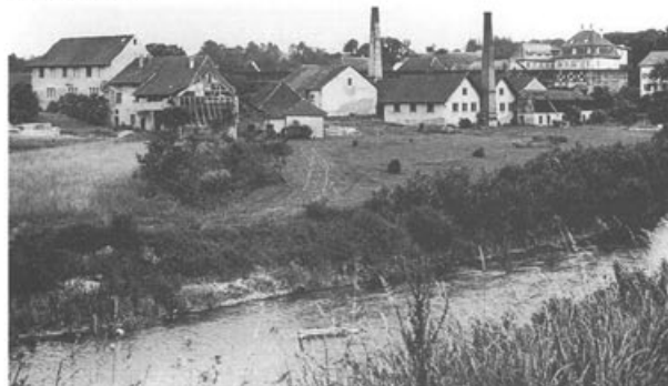
Abb. 4: Kaiseraugst AG. Dorfansicht mit der «Neuen Saline Kaiseraugst» kurz vor dem Abbruch im Jahre 1909. Blick von Westen.
