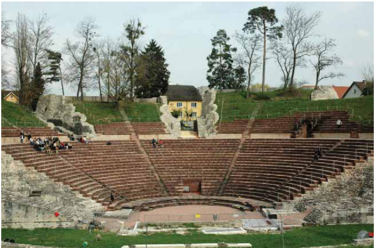
Abb. 2: Augst BL. Blick vom Schönbühl auf das 3. (szenische) Theater kurz vor Beendigung der langjährigen Sanierungsarbeiten. Auf den rekonstruierten Sitzstufen in der cavea lassen sich rund 2000 Personen unterbringen (bei einem Platzbedarf von 0,6 m pro Person), in der Antike fasste die cavea etwa 10000 Personen (bei 0,4 m Sitzfläche pro Person).
