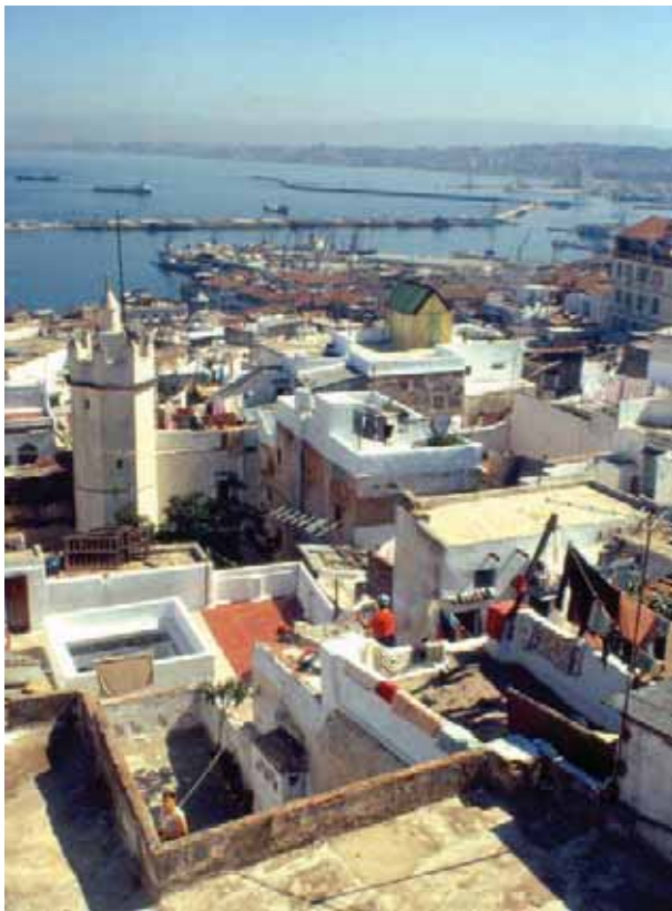
Abb. 18: Blick auf die Kasbah von Algier (Algerien). Im Jahr 1926 lebten hier auf 1 ha etwa 2250 Personen. Das heisst, jeder Einwohner verfügte über eine Wohnfläche von durchschnittlich 4,4 m 2 .
