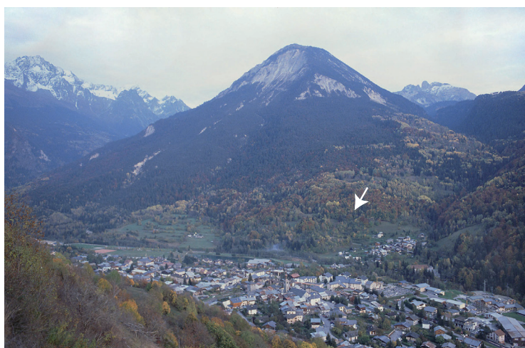
Figure 36. Topographie générale du pied de versant et du chaos rocheux (Lieu-dit Chenet des Pierres) au-dessus du hameau des Moulins (Relevé F. Jouvray, SCP Ferré-Fleurantin-Gentil). En bas : vue générale de la vallée de Bozel depuis la dent de Villard (la flèche blanche localise l'emplacement du site). Cliché et DAO : P.-J. Rey.
