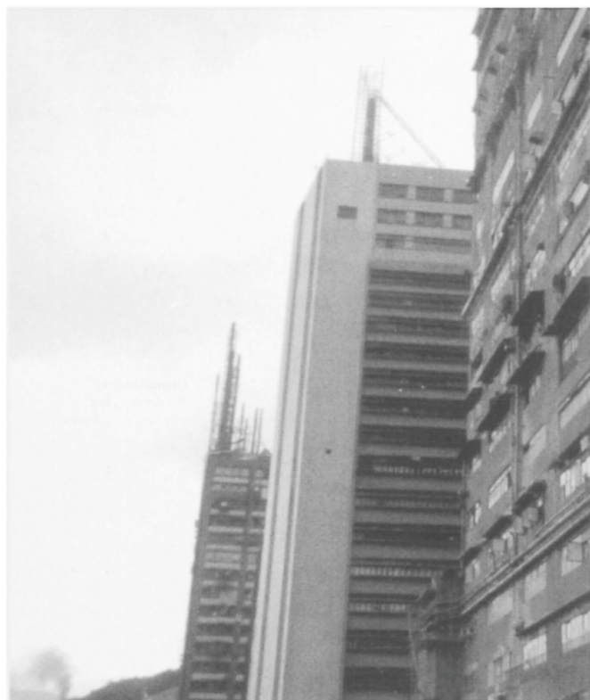
Fig. 4: Industrial area in Cheung Sha Wan Industriegebiet in Cheung Sha Wan Région industrielle à Cheung Sha Wan (Photo: W. BREITUNG März 1998)
