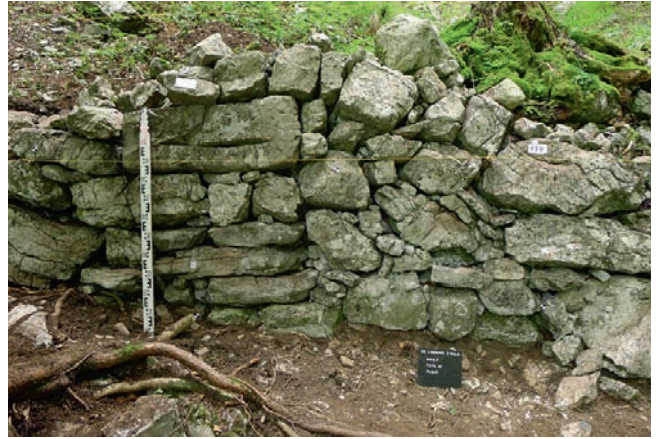
Abb. 5. Lungern OW, Balmiwald, Letzi (= Abb. 1,2). Blick von Süden an die Front der mittelalterlichen oder (früh)neuzeitlichen Letzimauer. Die gut erkennbare Baufuge spricht für Mehrphasigkeit. Foto AGP.
