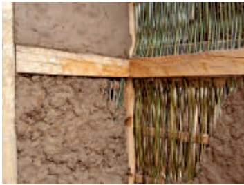
ABB. 12 Moderner Nachbau einer Fachwerkwand mit Rutengeflecht und Lehmewurf (Legionärspfad Windisch). Foto: Philippe Saurbeck
