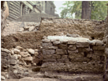
ABB. 21 Frontpartie des Murus Gallicus mit Steinen vorwiegend aus Tüllinger Süsswasserkalk, der am Kleinbasler Rheinufer unterhalb des Hörnlifelsens gebrochen wurde. Foto: Christian Bing.
