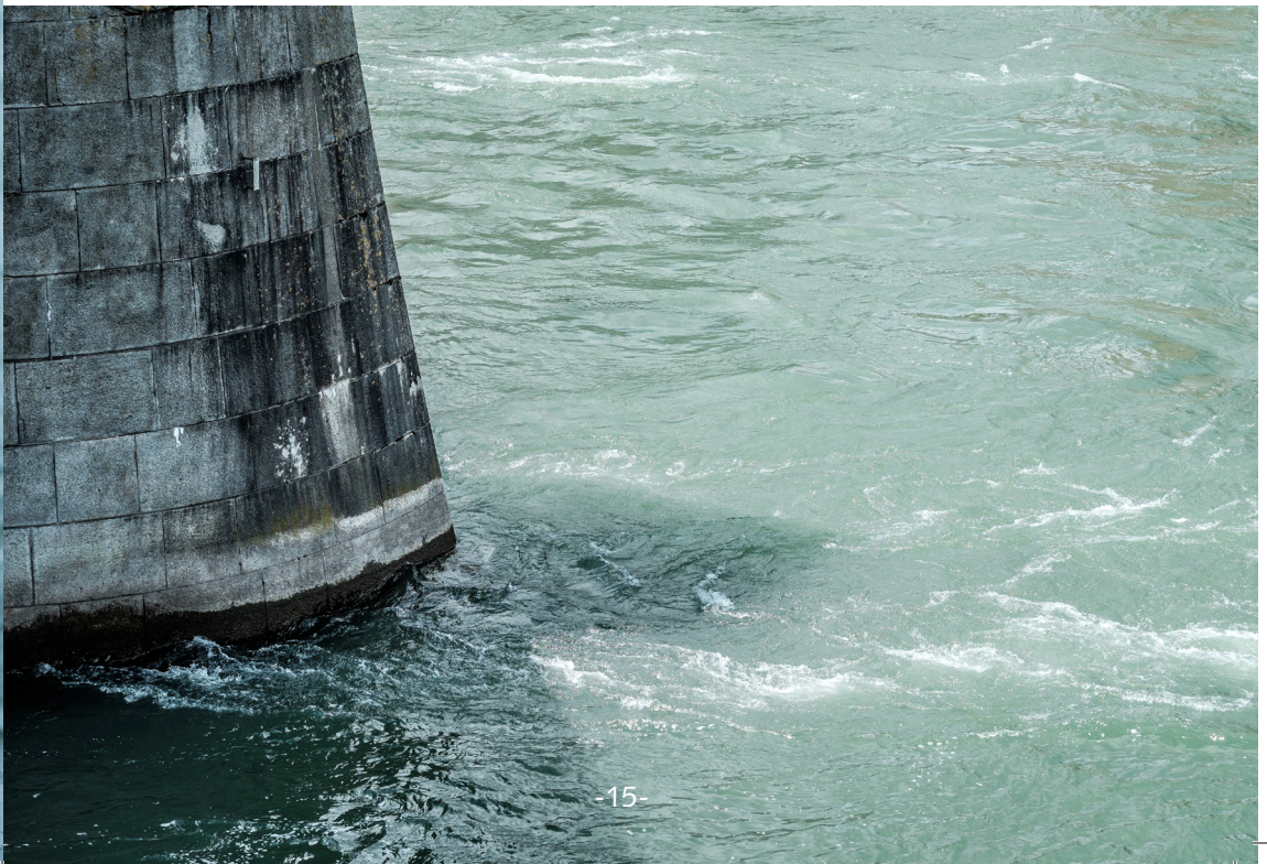
Abb. 8: Strömung an einem Brückenpfeiler der Mittleren Brücke
