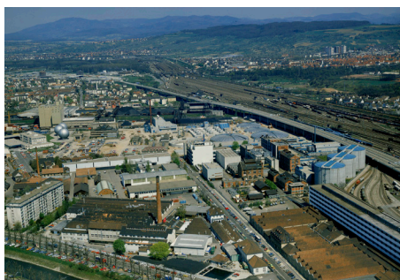
Abb. 25: Luftaufnahme aus dem Jahr 1982, Kleinhüninger Industriearial und Stückfärberei (im Vordergrund)
