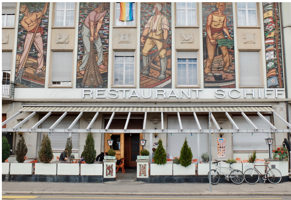
Abb. 19: Die Fassade des Restaurants Schiff
