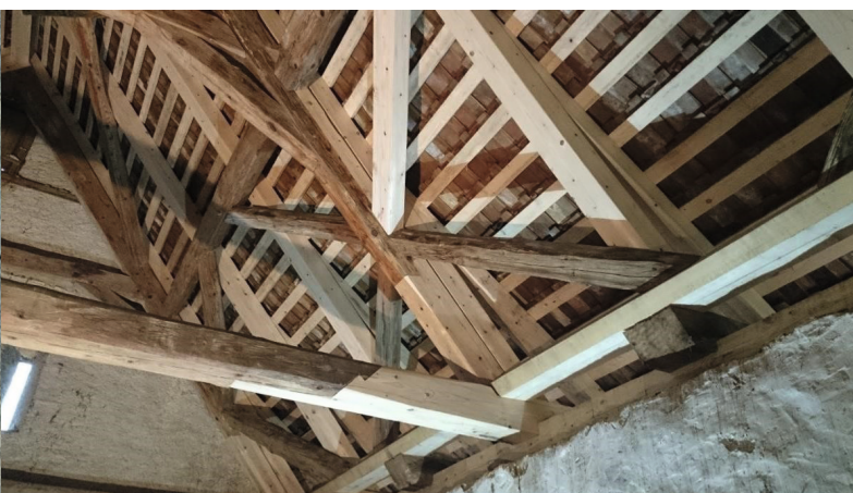
Abbildung 58: Anschäftung Bundbalken Stuhlstrebenfuss neue Stuhlschwelle mit Sparren und Aufschieblingen.
