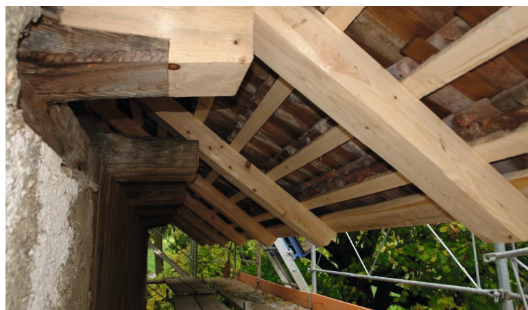
Abbildung 59: Dachfuss und Traufe.
