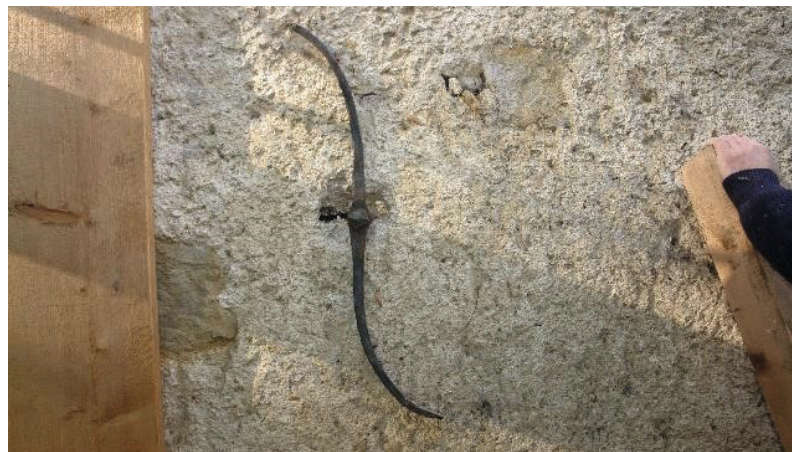
Abbildung 26: Zugstangenverankerungen mussten neu angebracht werden.
