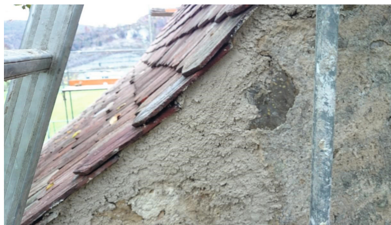
Abbildung 53: Detail Ortgang.
