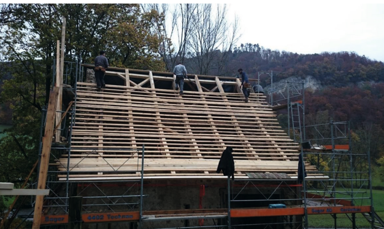
Abbildung 50: Dachlattung anschlagen.
