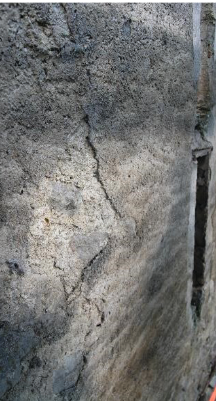
Abbildung 11: Wetterfront mit neuem Zementverputz.
