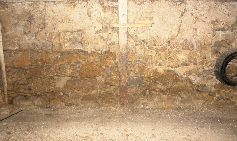
Abbildung 9: Mauerwerk, hangseitig, im Stall.
