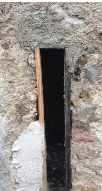
Abbildung 29: Holzrahmen wurden nur wo nötig ersetzt. Verputz an alten Holzrahmen ergänzt.
