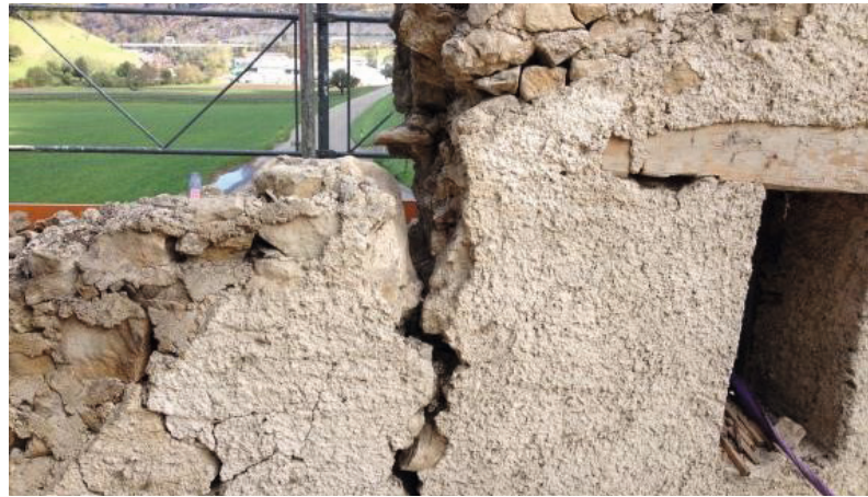
Abbildung 24: Grosser Mauerabbruch Ost-Seite bis zum Lüftungsschlitz abgebaut.
