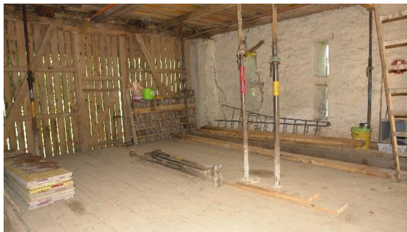
Abbildung 17: Holzverschalung beim Heuboden.
