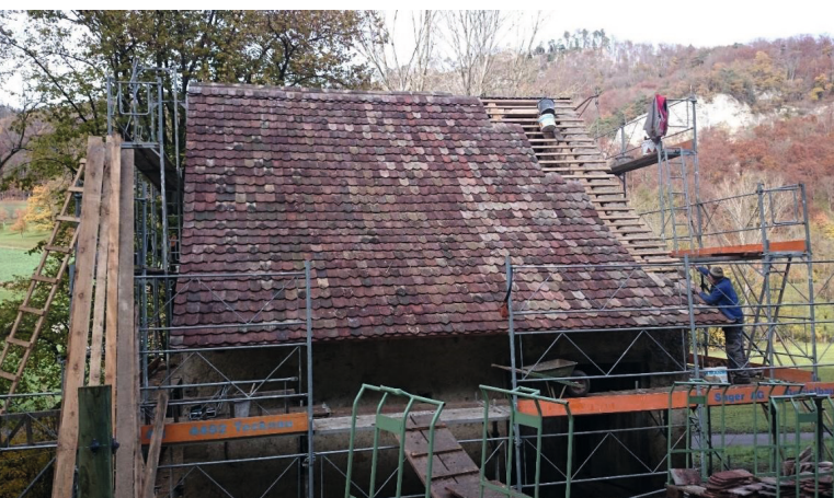
Abbildung 52: Ziegeldecken mit vermörtelte Firstdeckung.
