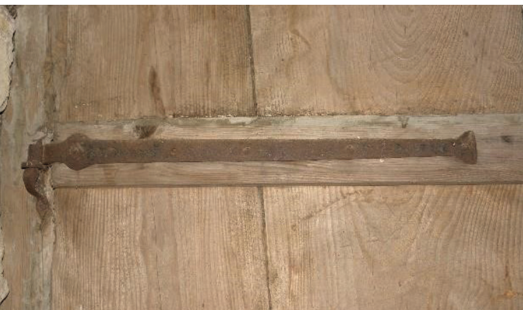
Abbildung 16: Eisenbeschlag des Holztores zum Heuboden.
