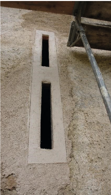
Abbildung 40: Lüftungsschlitz der Ostfront, frisch renoviert.
