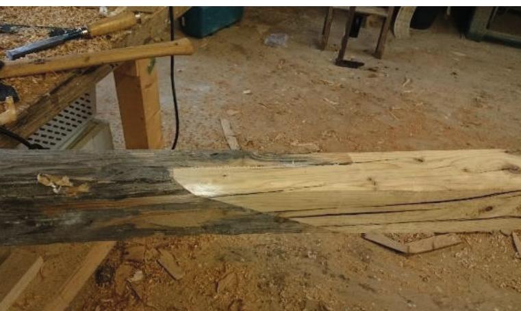
Abbildung 35: Reparaturverbindung an Andreaskreuzstrebe: beidseitig schräg eingeschnittenes Längsblatt.
