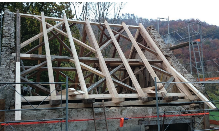
Abbildung 48: Sparrenlage und Aufschieblinge.
