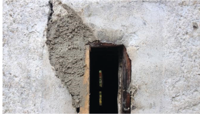
Abbildung 28: Kalkverputz grob ergänzt und „nass in nass“ Feinputz darüber mit Kelle glatt gestrichen.
