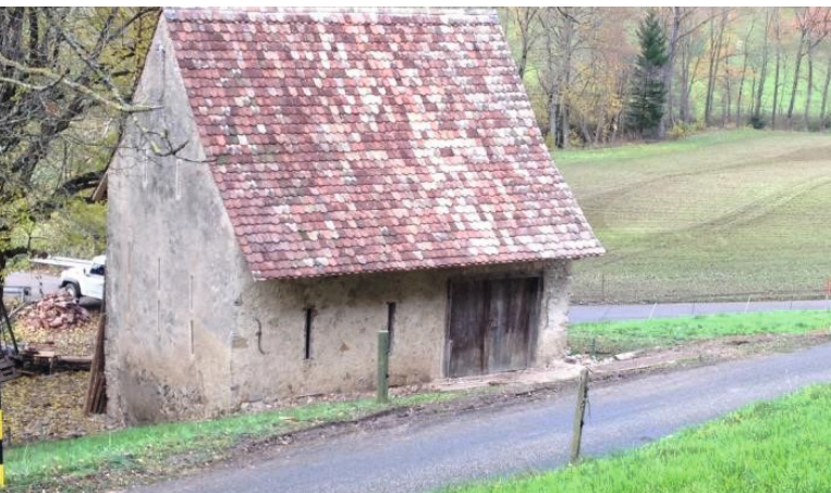
Abbildung 37: Feldscheune Rötler/Chrummacher, Zustand am Ende der Instandstellungsarbeiten. Blick Süd/Nord.
