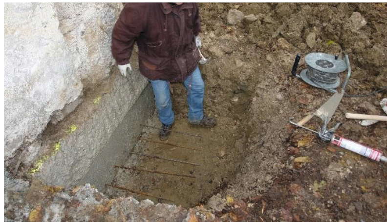
Abbildung 25: Strebepfeiler wurden mit Betonfundament unterfangen.
