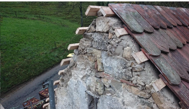
Abbildung 54: Detail First mit ergänztem Mauerwerk.
