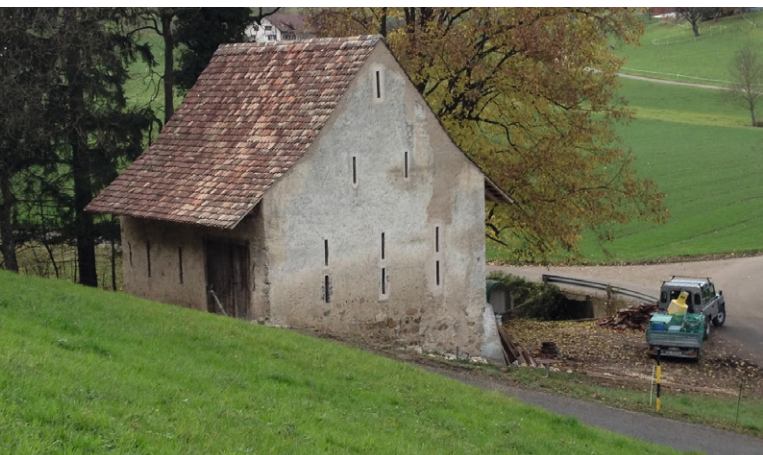
Abbildung 39: Feldscheune Rötler/Chrummacher, Zustand am Ende der Instandstellungsarbeiten. Blick Ost-West.
