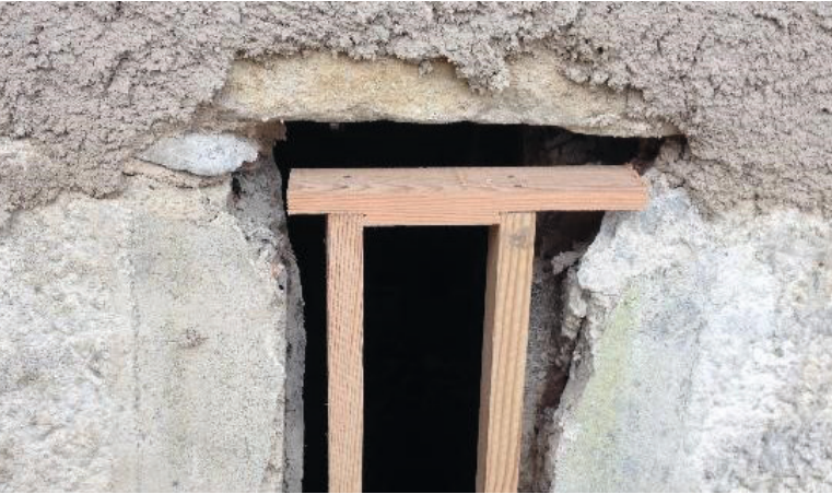
Abbildung 27: Neuer Holzrahmen eines Lüftungsschlitzes wird eingepasst. Oberhalb der Fensteröffnung musste ein neuer Natursteinsturz eingemauert werden.
