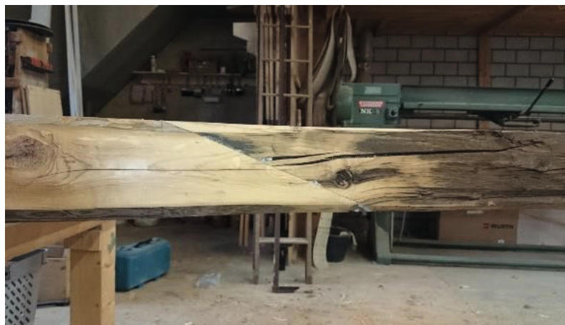
Abbildung 34: Mit Reparaturverbindung angeschäfter Firstanschluss an einer Andreaskreuzstrebe.
