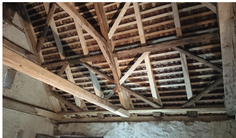
Abbildung 57: Ergänzungen und Anschäftungen Dachfuss Süd.
