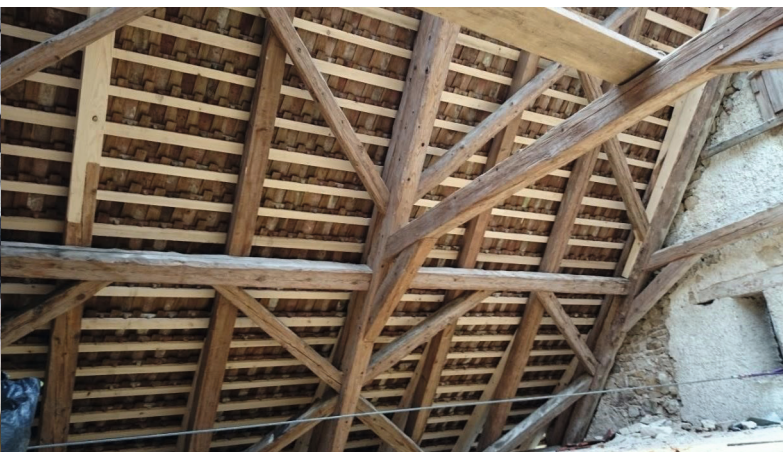
Abbildung 56: Dachfläche innen mit Schindeln.
