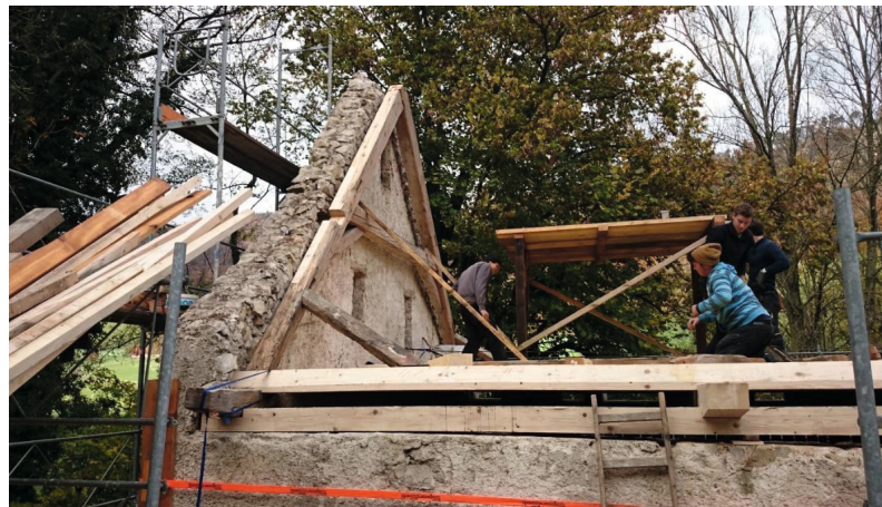
Abbildung 45: Aufrichten Binder West.
