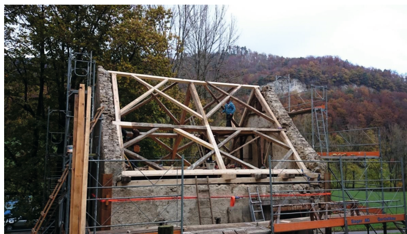
Abbildung 47: Der Dachstuhl ist aufgerichtet.
