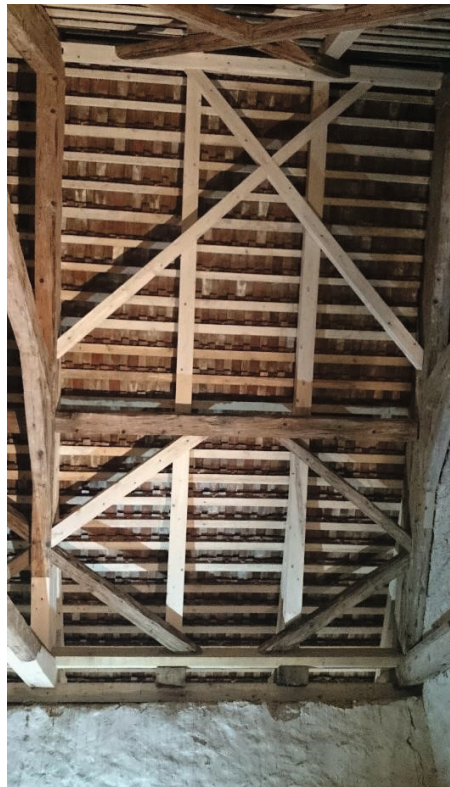
Abbildung 41: Windverbände. Altes Holz konnte wiederverwendet werden.
