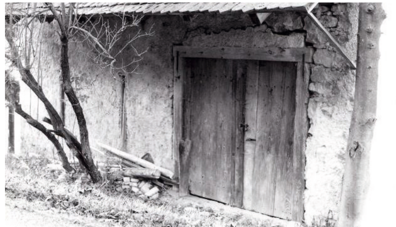
Abbildung 4: Zugang zum Heuboden, Süd-Nord
