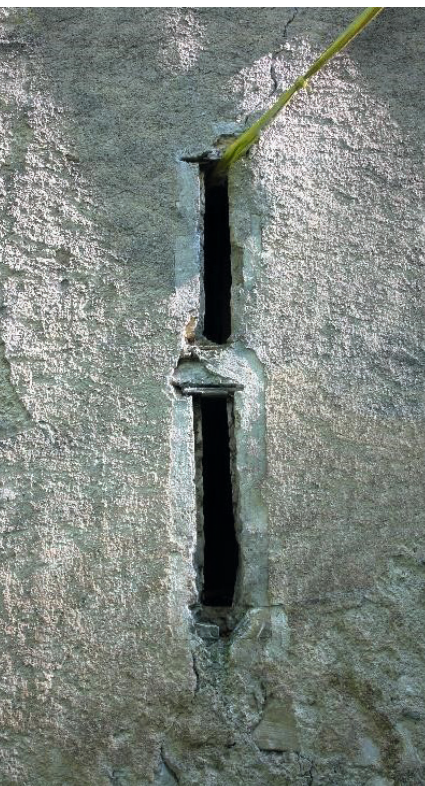
Abbildung 5: Lüftungsschlitz an der Ostseite.
