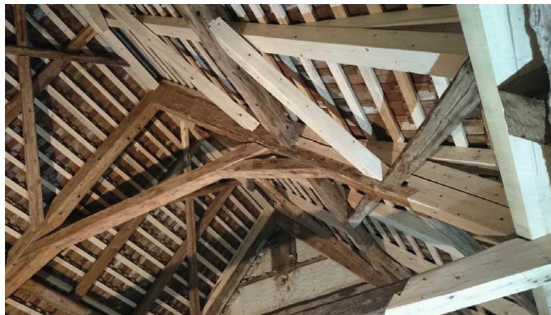
Abbildung 38: Dachstuhl saniert und frisch gedeckt. Blick West/Ost.
