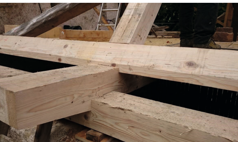
Abbildung 46: Mauerbalken Bundbalken Stuhlschwelle und Strebe Balkenkopf noch unverputzt.
