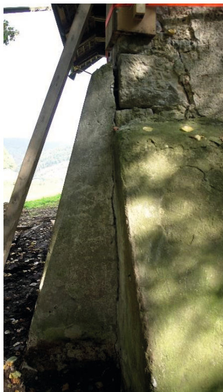
Abbildung 6: Strebepfeiler an der Südfassade.
