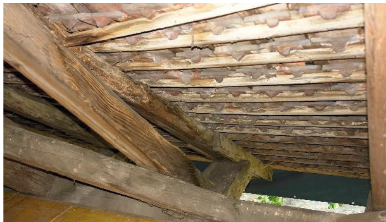
Abbildung 19: Stuhlschwelle.
