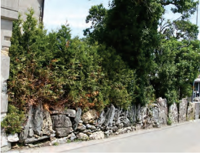
Abb. 608. Die Einfassungsmauer des Gartens an der Strasse; links ein Block mit einer (horizontalen) künstlichen Rinne.
