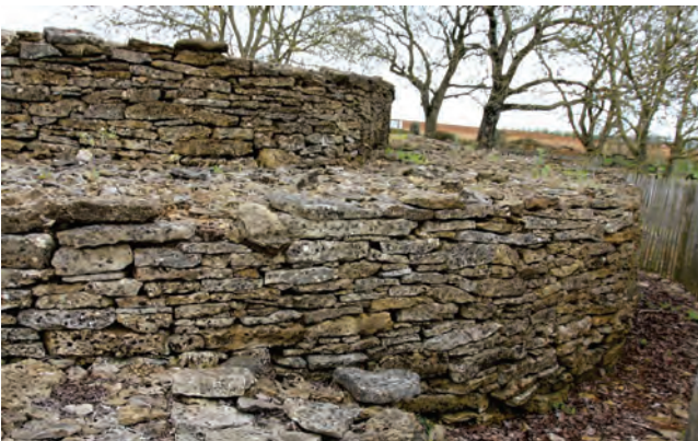
Abb. 229. Foto eines Teils des eingezäunten Ganggrabes La Ciste des Cous, von Südwesten. Die Anlage kann wegen Einsturzgefahr nicht betreten werden.
