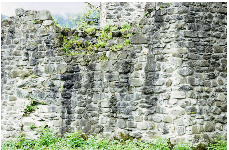
Umfassungsmauer, Mauer M5A, Blick gegen Süden. Intaktes Originalmauerwerk mit zum Teil bis zu den Steinköpfen reichendem Mörtel. Foto AAM, 2012
