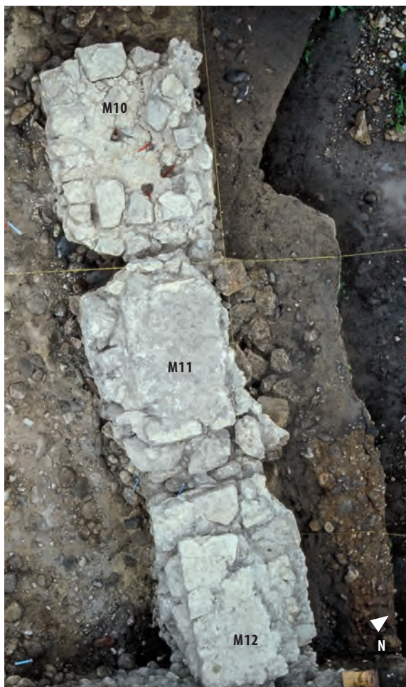
226 Windisch-Bachthalen 2007–2009 (V.007.3). Horizont IV. Die drei Punktfundamente M10–M12 der porticus der Parzelle 12 zeigen unterschiedliche Erhaltungszustände. Während bei M11 und M12 das aufgehende Mauerwerk noch erhalten ist, fehlt es bei M10. Die Löcher Pf12.33 in diesem Fundament könnten Spuren der Beraubung sein, welche demnach mit einem Brechisen erfolgte, das zum Auseinanderbrechen der Mauer in den Mauerkern geschlagen wurde.
