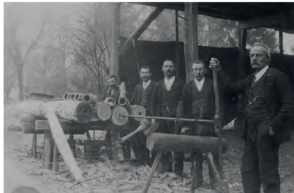
179 Teuchelbohrer um 1905, in Sursee, Luzern. Zu beachten sind die Böcke zum Aufspannen der Teuchel und der zusätzliche Bock mit dem Führungsseisen für den Teuchelbohrer.
