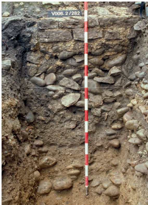
101 Windisch-Bachthalen 2006–2007 (V.006.2). Parzelle 12. Phase III.5. Blick an die freigelegte Seite des Punktfundaments M13. Die Gliederung in ein geschüttetes Fundament, zwei vermörtelte Fundamentlagen sowie zwei sorgfältig aufgemauerte Lagen Mauerwerk sind gut zu erkennen. Eine dritte Lage des Aufgehenden ist wahrscheinlich ausgeraubt worden. Blick nach Süden
