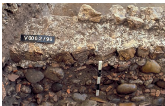
78 Windisch-Bachthalen 2006–2007 (V.006.2). Parzelle 10. Phase III.5. Detail M15. Zwischen den Fundamentlagen aus Gerölln ist jeweils eine Ausgleichsschicht aus zerbrochenen Ziegeln eingebracht. Auf die oberste Ziegellage wurde eine Mörtelplatte gegossen, auf welcher das Aufgehende aus vermörtelten Kalkbruchsteinen aufliegt. Blick nach Norden.
