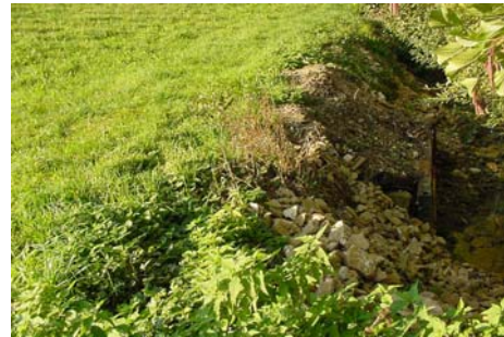
übermäßige Uferbefestigung, fehlende Uferzone
