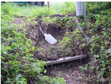
Uferböschung mit Messblechen
