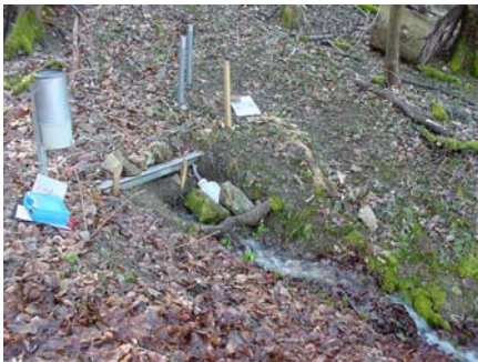
Messeinrichtung an einer Länenbach-Quelle
